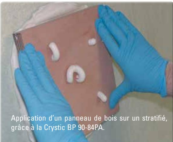
Application d'un panneau de bois sur un stratifié, grâce à la Crystic BP 90-84PA.
